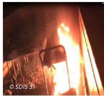
ARIA 54538 – Incendie à la suite d'un emballement thermique d'un élément et propagation aux autres batteries.
